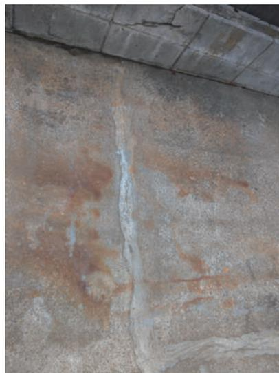
上記の写真はアルカリ骨材反応（ASR）が発生し、中性化したために内部の鉄筋が錆びが生じている現象です。このような場合にはウルトラテクト CA+3 と S ウルトラテクト Li の併用を推奨します。
