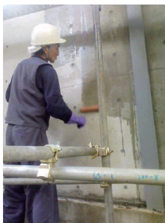
ローラーにて施工の様子
