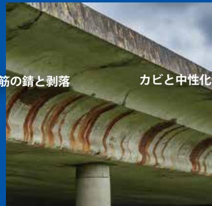
鉄筋の錆と剥落 カビと中性化現象
