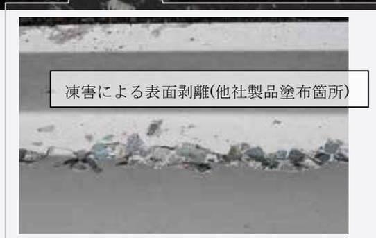
凍害による表面剥離(他社製品塗布箇所)
