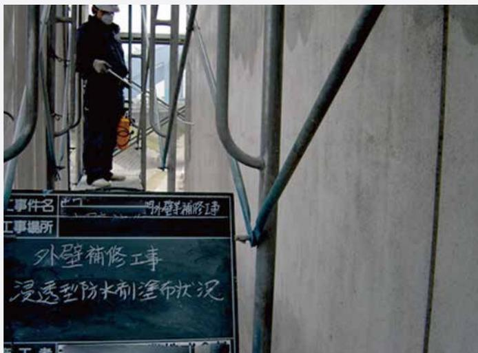
コンクリート構造物の外壁補修工事。スプレーを用いて塗布
