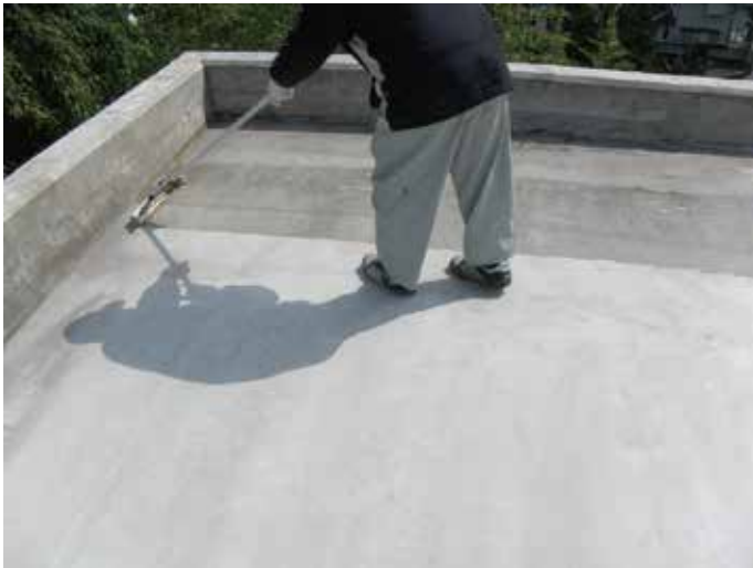
在應用 Ultratect WR 之前修復裂縫和接縫
