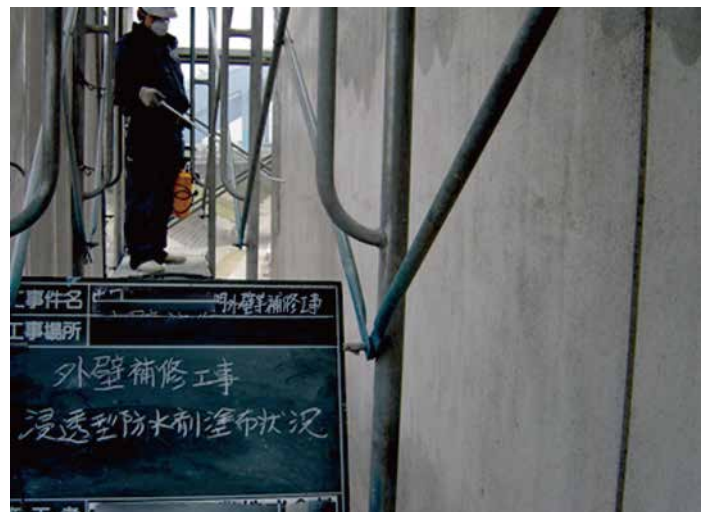
適用於混凝土牆面防水、防黴、防污目的
