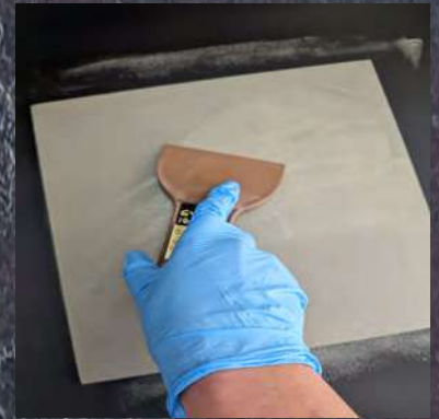
ラバーベラを用いて左に折り返す。左へと右へとラバーベラを当てながら好みのパターン付けをしてください。
