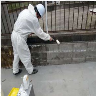
正在安裝 ULTRATECT®HP。 透過對基材進行改性，可以防止漆膜起泡。 也可減少漏水並防止混凝土滲漏。 貢獻。
